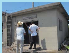
御崎漁港内作業小屋
